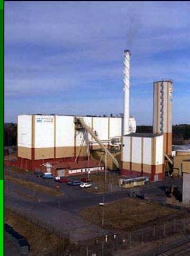
Cogeneration plant, Nässjö, Sweden. Source: www.vattenfall.se
