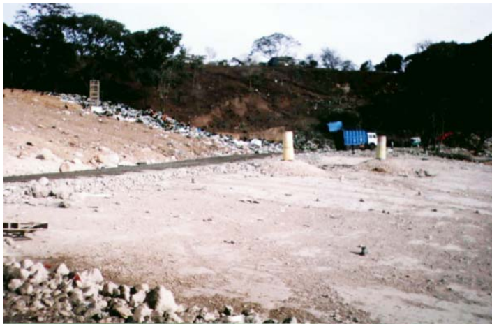
Figura 1. Vista del Sello de Arcilla y Chimeneas
