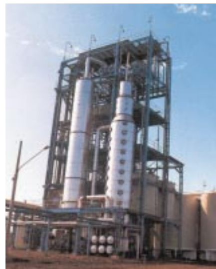
Figure 3. Distillation column from an ethanol production facility (Source: Cooperativa de Produtores de Cana Açúcar e Alcool de São Paulo Ltda - Copersucar, Brazil)
